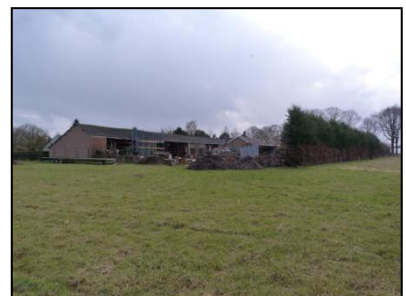
Figuur 8. Achterzijde bedrijfsterrein.
