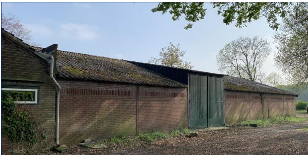
Te slopen voormalige agrarische bedrijfsbebouwing
