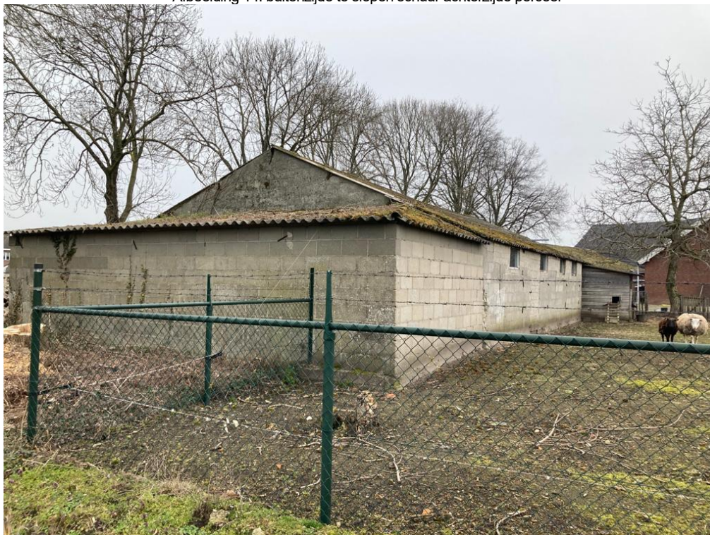
• Afbeelding 14: buitenzijde te slopen schuur achterzijde perceel
