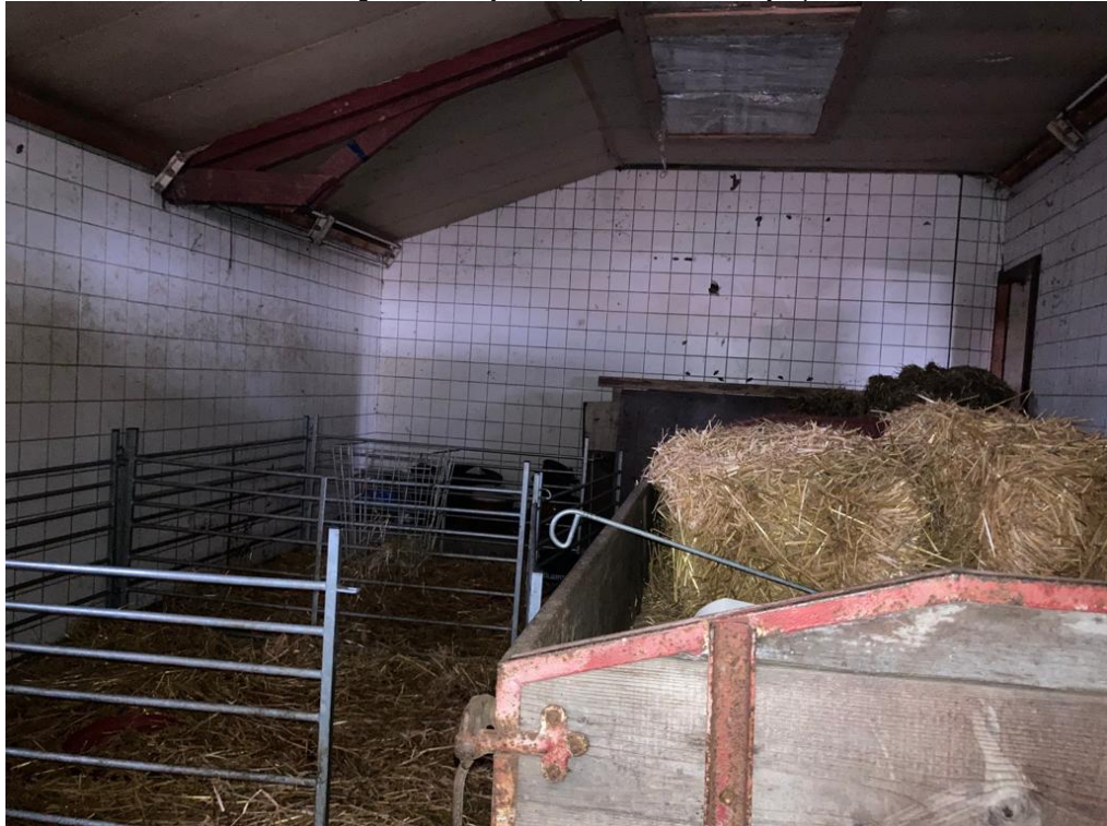
• Afbeelding 12: binnenzijde te slopen schuur achterzijde perceel
