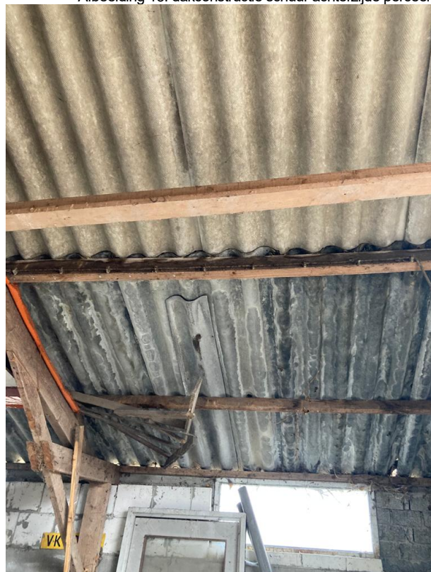
• Afbeelding 13: dakconstructie schuur achterzijde perceel
