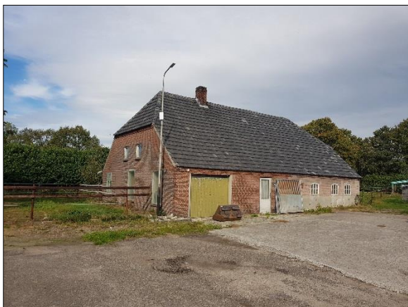
Figuur 6. Bedrijfsgebouw C, blijft vooralsnog behouden
