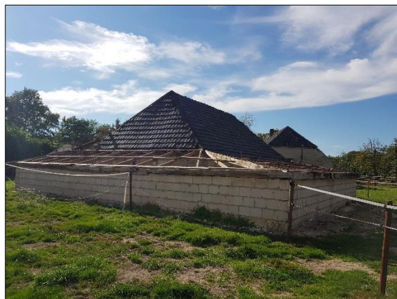
Figuur 7. Bedrijfsgebouw D
