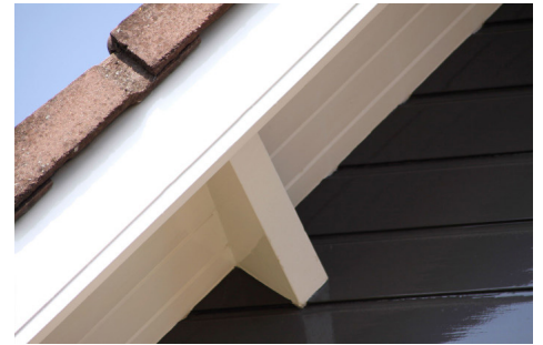
Een daklijst kan de dakvorm versterken
