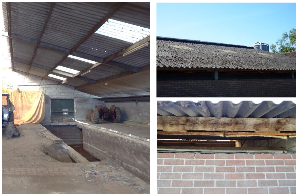
Afbeelding 7. Dak van de stal in het plangebied (foto's Laneco, 2020)
