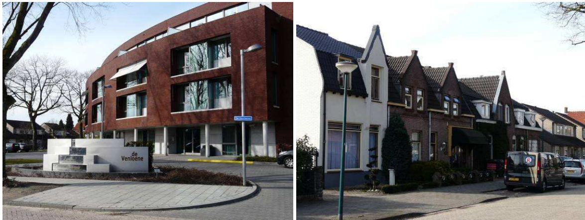
Woonzorgcentrum De Venloene en woningbouw aan de Van Rijckevorselstraat
