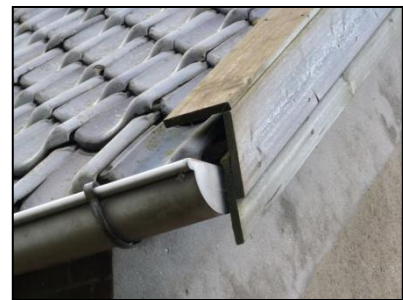
Figuur 13. Toegang via de dakgoot.
