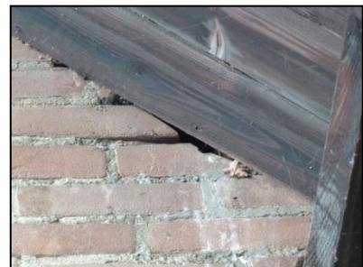
Figuur 16. Opening langs de dakrand.
