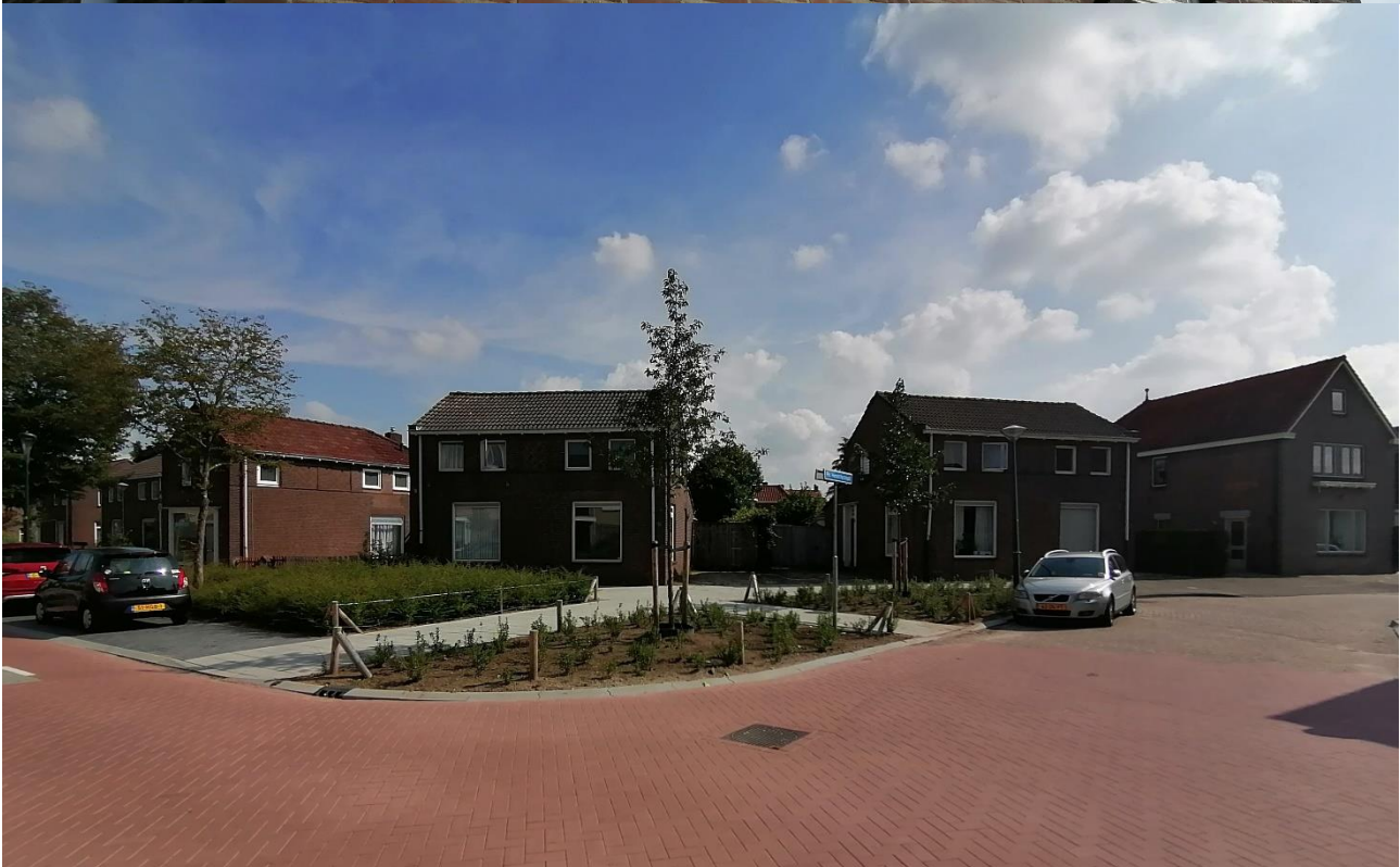
Boven: Kopgevel. Geen spouwopeningen, maar onder de kantpannen zijn openingen aanwezig. Onder: Overzichtsfoto van het zuidelijke deel van het plangebied.
