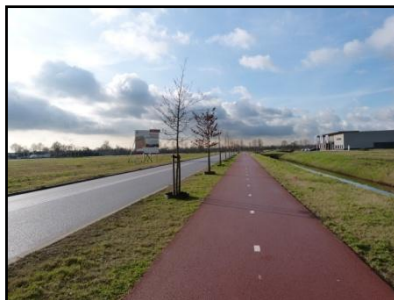
Figuur 13. Reeds gerealiseerde infrastructuur (Belgiëstraat).
