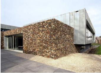
Diepe negges voor extra plasticiteit gevelbeeld en schanskorven
