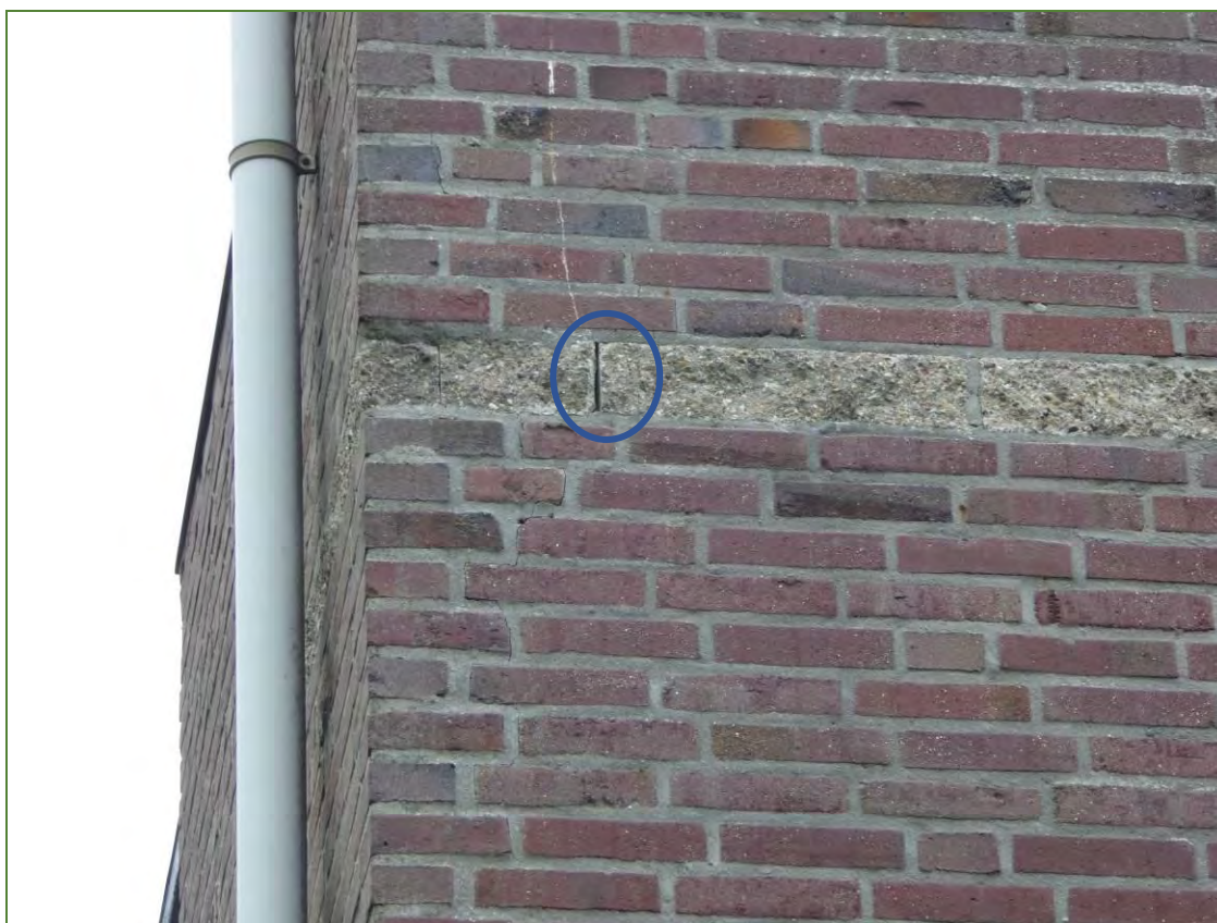
Foto 4: de voeg tussen de betonnen sierrand op de sportzaal is verdwenen en kan door (dwerg) vleermuizen gebruikt worden.
