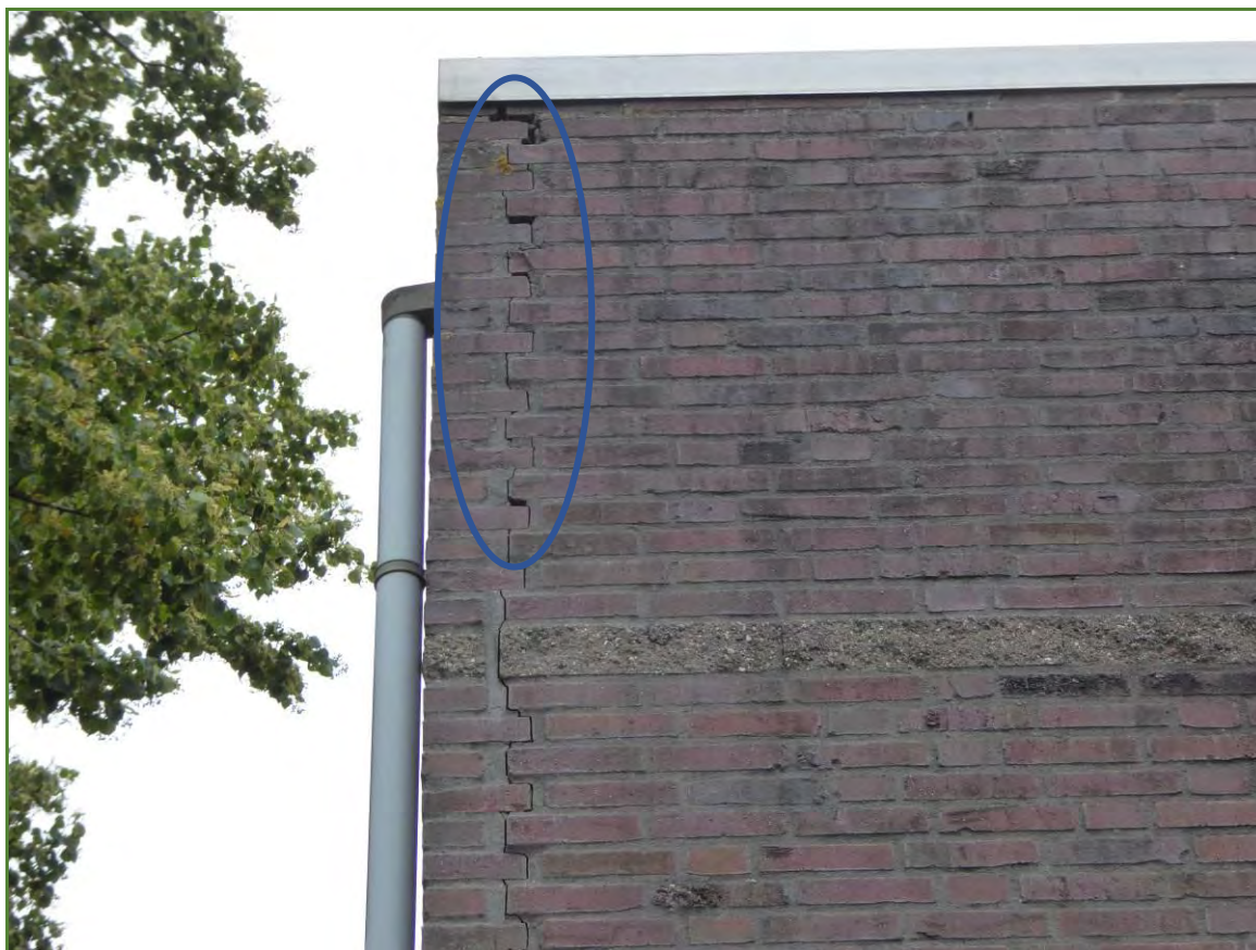
Foto 7: de sporthal. De bredere delen van de scheur (blauw) in de muur kan door vleermuizen worden gebruikt.
