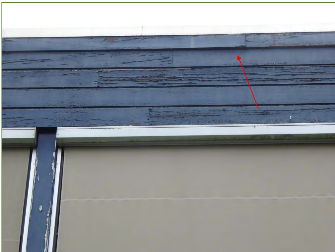
Foto 9: planken boven de ramen wijken op een aantal plaatsen van elkaar. Van de opening en ruimte achter de planken kunnen vleermuizen gebruik maken.
