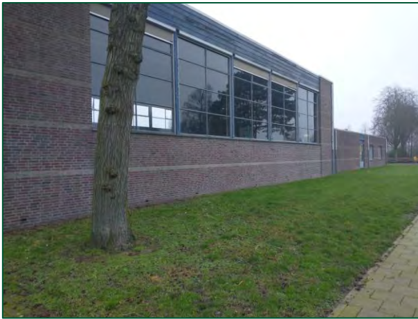
foto 2: Gymzaal bij het schoolgebouw met aan de bovenkant aftimmering
