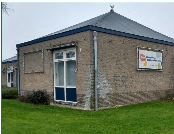
foto 9: een zijde van het kinderdagverblijf met dicht tegen de gevel een aantal bosshages. Er zijn geen scheuren of kieren aanwezig in de gevel
