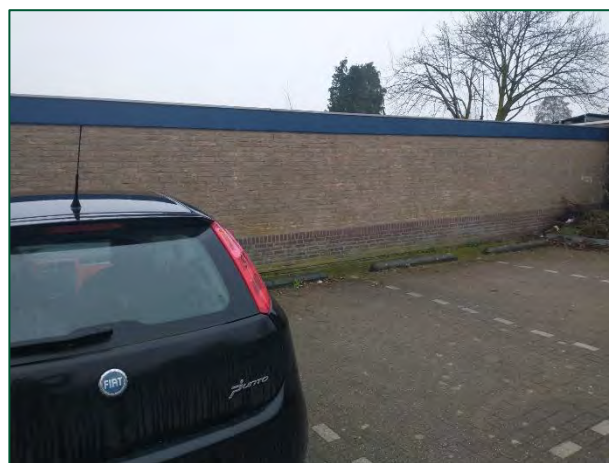
foto 12: Achterzijde van de opslag op het terrein van het kinderdagverblijf
