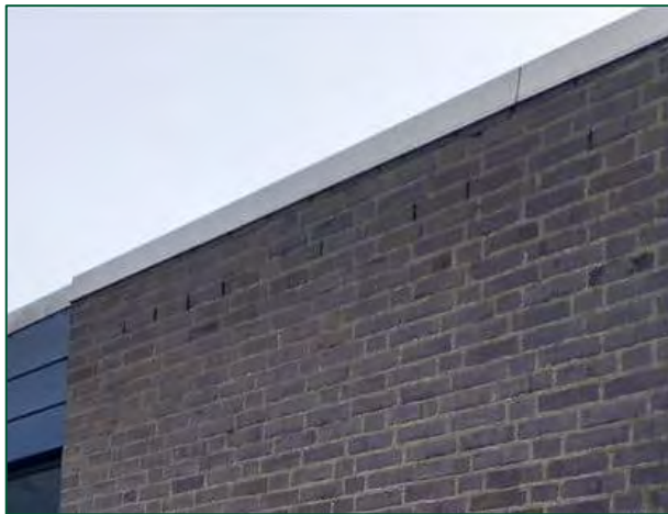
foto 5: Vergroting van foto 3 met duidelijk de stootvoegen zichtbaar
