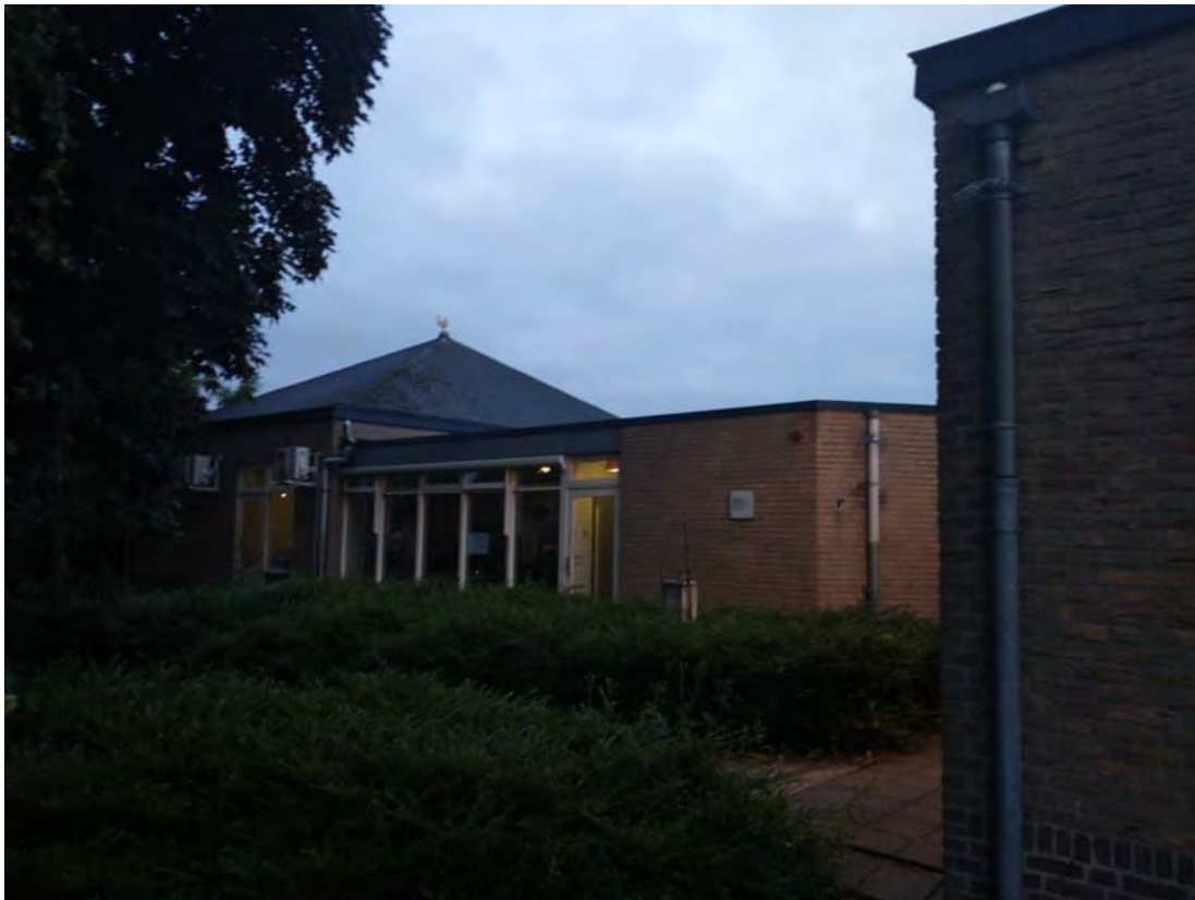
Figuur 5: het gebouw was redelijk verlicht.
