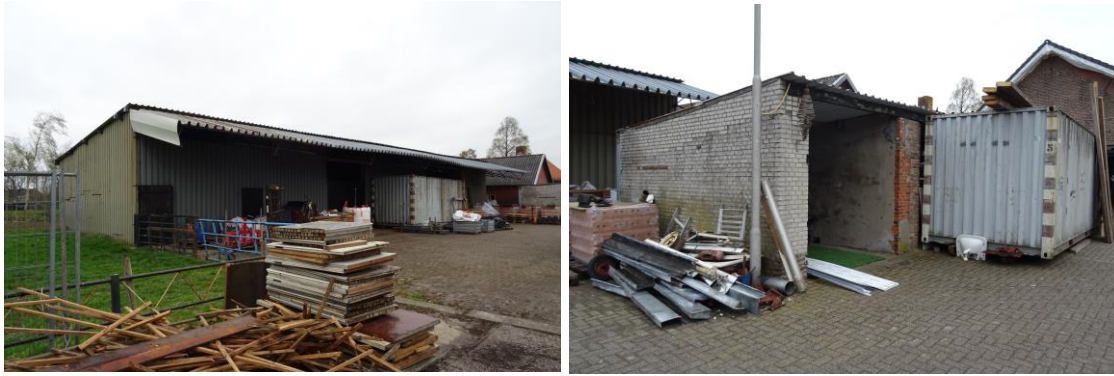
Afbeelding 3 en 4: Bestaande te slopen bebouwing. Bron: BNL advies. Datum: 06-04-2022
