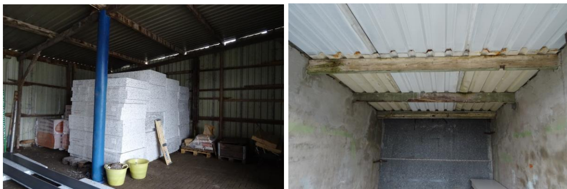
Afbeelding 7 en 8: daken en wanden van enkel plaatmateriaal of muren zonder spouw. Bron: BNL advies. Datum: 06-04-2022
