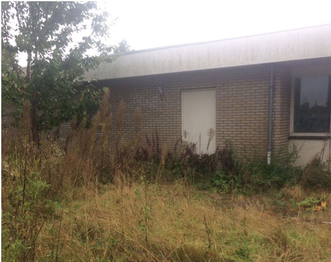
Figuur 15: Het plangebied gezien vanaf boorpunt 6 in noordwestelijke richting
