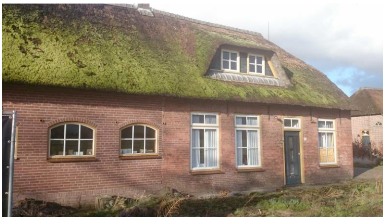
Boerderij (gebouw A) vanaf de weg gezien.
