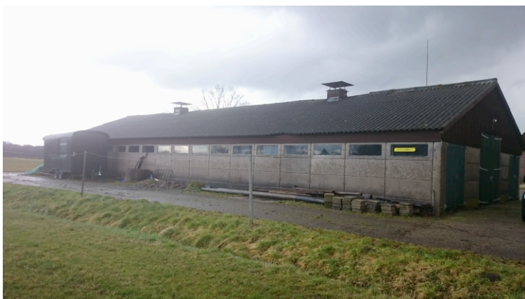
Stal, gebouw B. De ruimte achter de bruine gevelbetimmering is potentieel geschikt voor vleermuizen als vaste rust- of verblijfplaats. Onder de golfplaten dakbedekking is ruimte aanwezig waar huismus en
