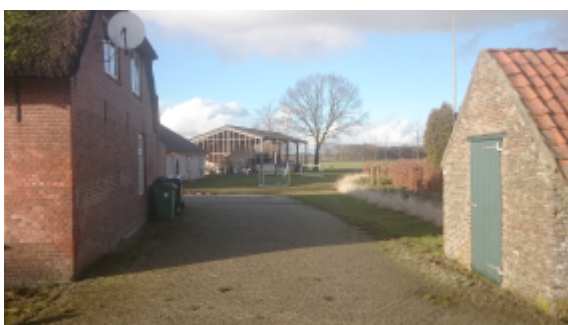
Bebouwing en verharding binnen het plangebied. In de nok van de open schuur op de achtergrond is de steenuil gevonden.
