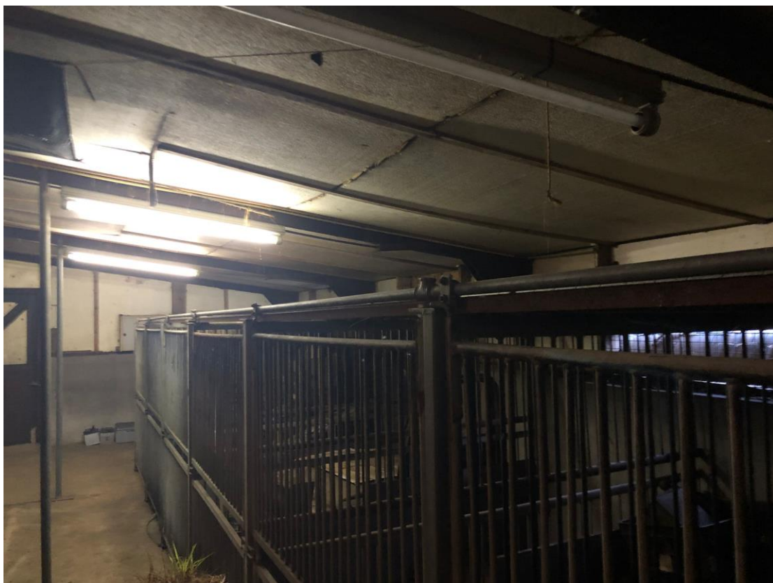
Figuur 7a: Inwendige te slopen staldeel, kijkende van oost naar west.
