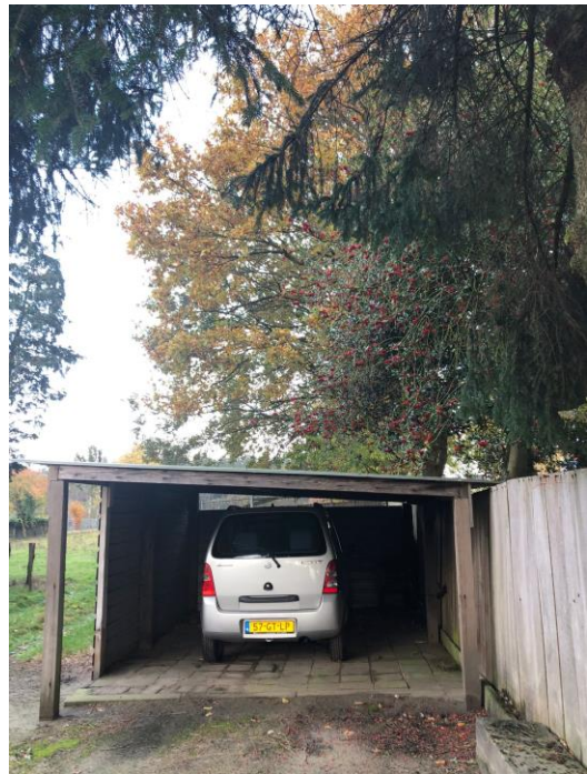
Figuur 7l: geïnspecteerde overdekte parking.
