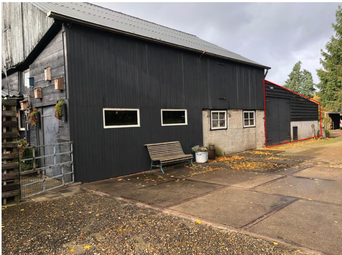
Figuur 6a: Close up van het te saneren staldeel (rode arcering) en hoofdschuur met hooizolder.
