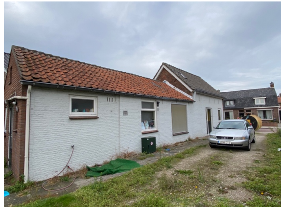
Figuur 5 Linker zijgezicht woonhuis.
