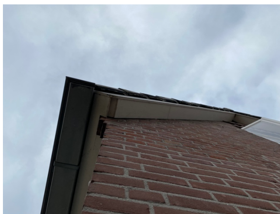
Figuur 15 Detailfoto voorkant woonhuis, naast de toegankelijke ruimte onder de gevelbetimmering is er potentieel ook ruimte voor vleermuizen om onder de dakpannen te komen.
