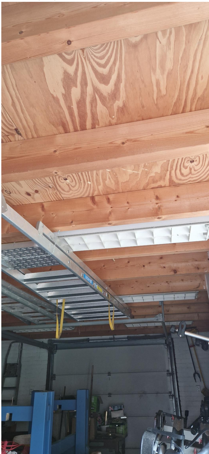
Plafond in garage onder het platte dak:
