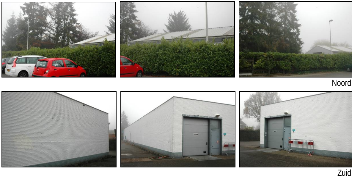
Figuur 2. Foto-impressie van de reconstructielocaties.
