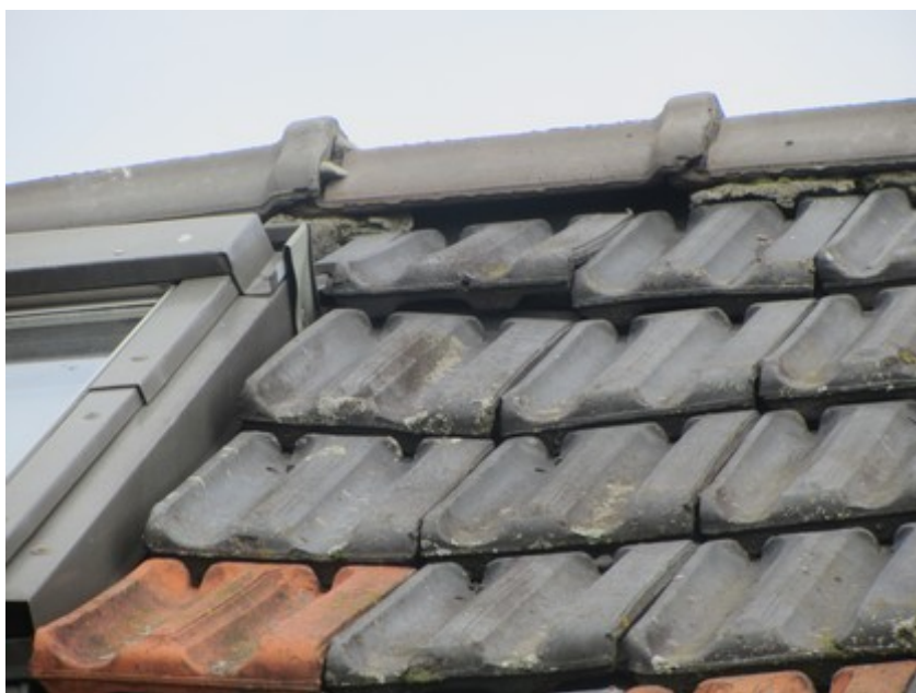
Zuidkant van bakstenen schuur, wijkende dakpannen en ruimte onder nok. Grenzend aan plangebied. Foto: V. Stuit| Ecoresult B.V.
