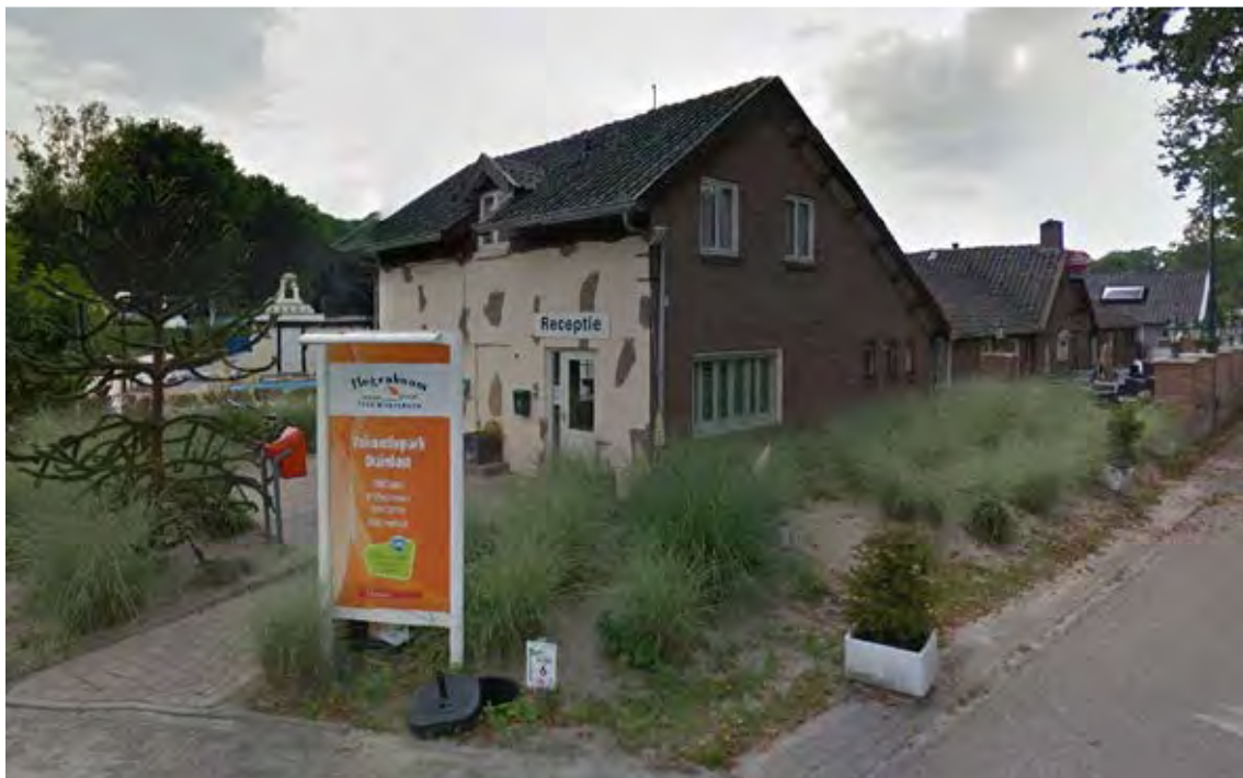
Afbeelding 5 Streetview opname (2016) van de huidige bebouwing ten zuiden van de Duinlaan. Het deelgebouw waar Receptie op staat komt qua ligging overeen met de locatie van de bebouwing op de minuut. Bron: Google Earth.
