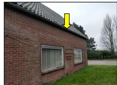
Figuur 7. Ruimtes langs de dakrand bieden toegangsmogelijkheden tot onder het dak.
