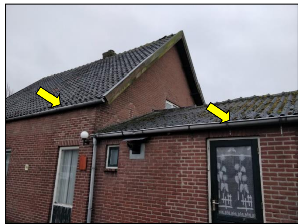
Figuur 4. Ruimtes tussen het dak en de dakgoot bieden potentieel geschikte ruimtes voor de huismus.
