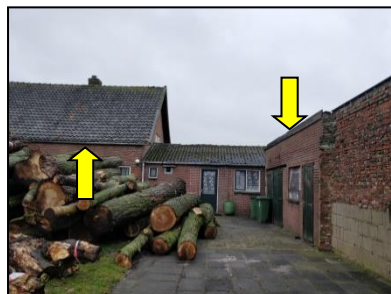
Figuur 6. Ruimtes langs de dakrand bieden toegangsmogelijkheden tot onder het dak.
