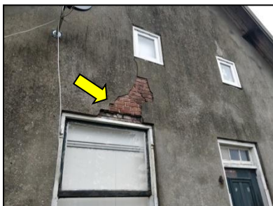
Figuur 5. Stootvoegen bieden toegangsmogelijkheden tot de spouwmuur.
