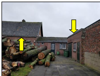
Figuur 13. Ruimtes langs de dakrand bieden toegangsmogelijkheden tot onder het dak.
