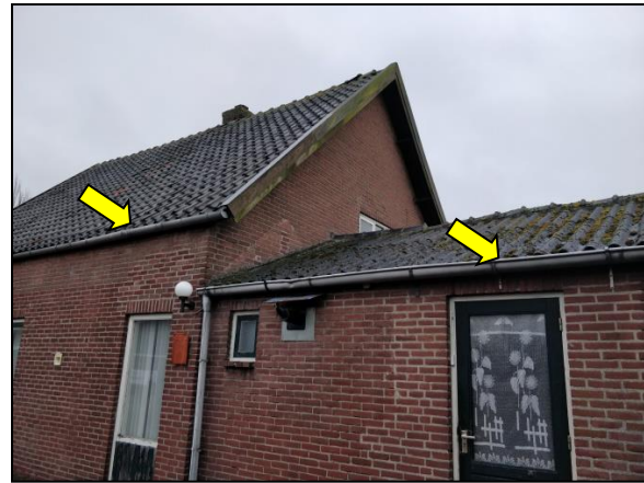
Figuur 11. Ruimtes tussen het dak en de dakgoot bieden potentieel geschikte ruimtes voor de huismus.
