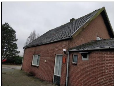
Figuur 3. Het huidige woonhuis.
