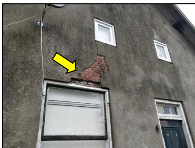
Figuur 12. Stootgaten bieden toegangsmogelijkheden tot de spouwmuur.
