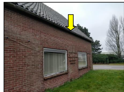
Figuur 14. Ruimtes langs de dakrand bieden toegangsmogelijkheden tot onder het dak.
