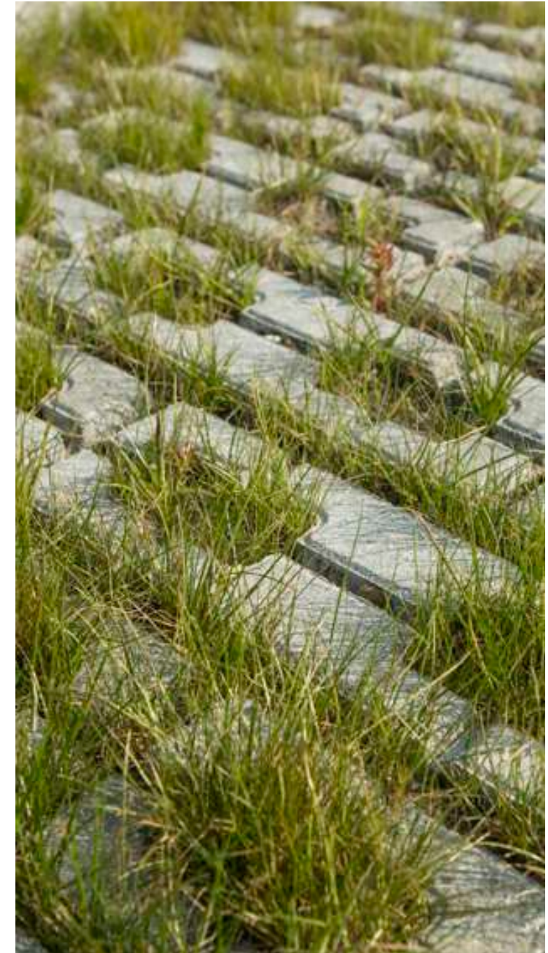
Grasbeton voor de parkeerplaatsen, voorkomt hittestress en heeft natuurlijke uitstraling
