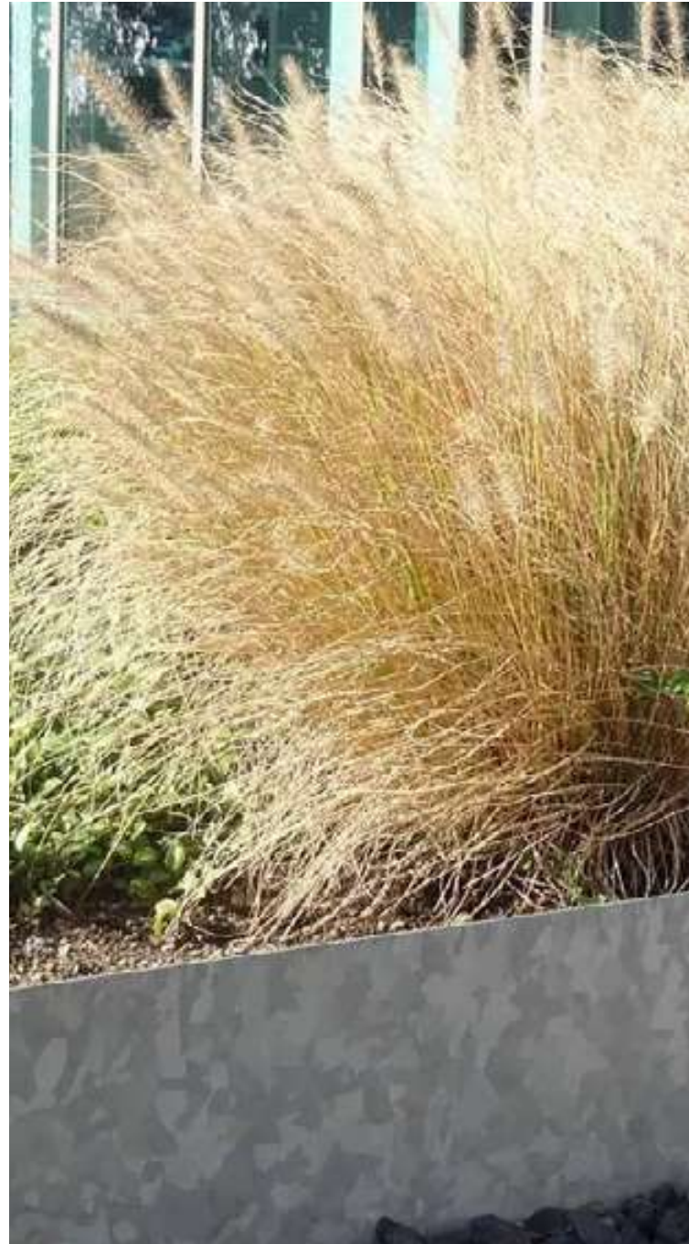
Thermisch verzinkt stalen kantopsluiting Verlaagd waar kan, verhoogd waar nodig
