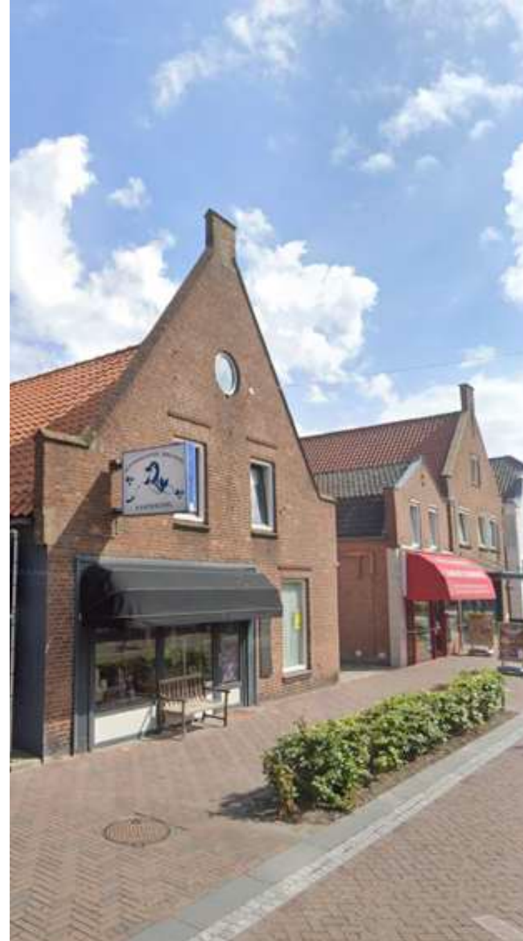
De te slopen gebouwen aan de Hoofdstraat in Kaatsheuvel.
