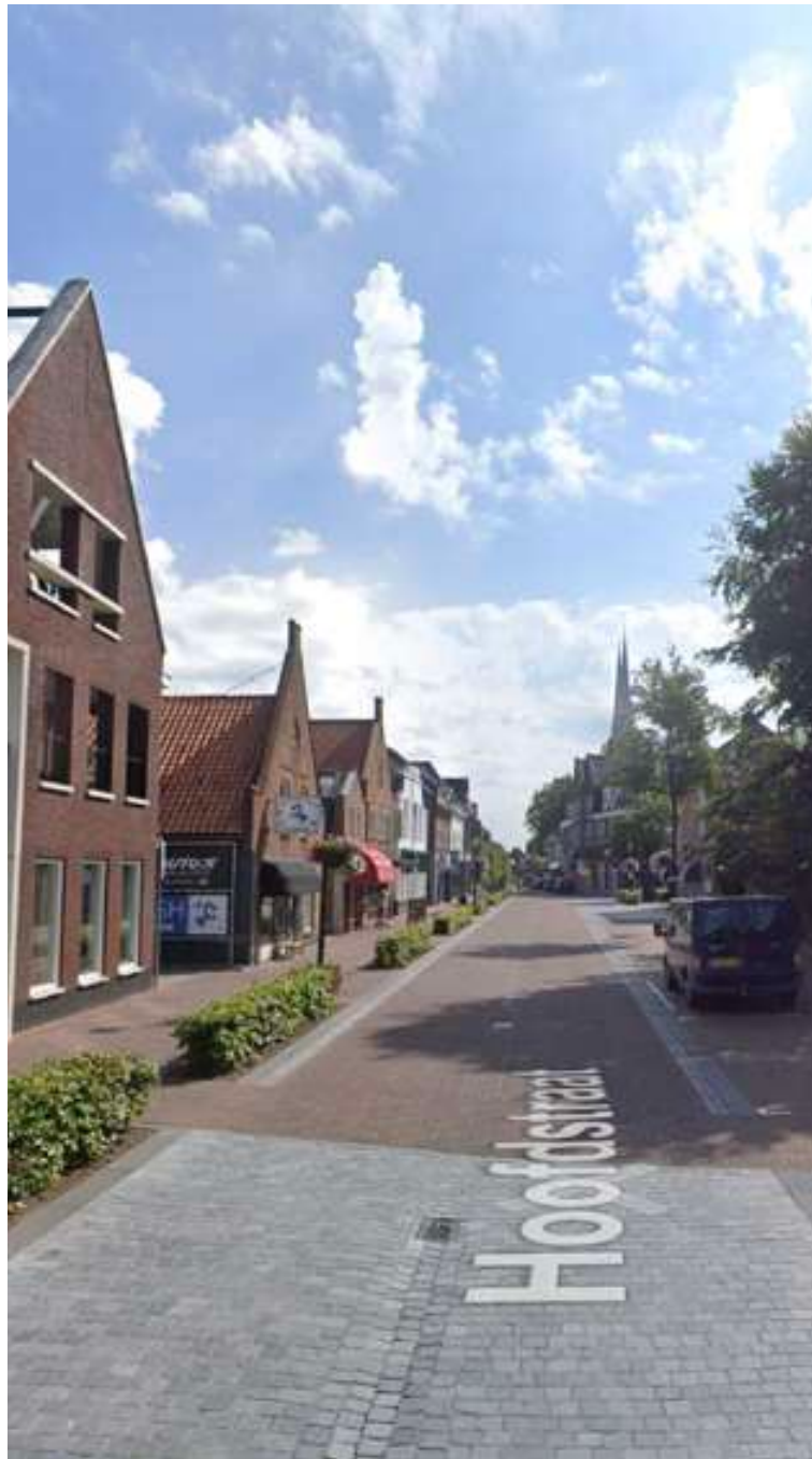
Het dorpse karakter van de Hoofdstraat. Onlangs is de openbare ruimte opnieuw gerealiseerd. Aan de linkerzijde de te slopen gebouwen.
