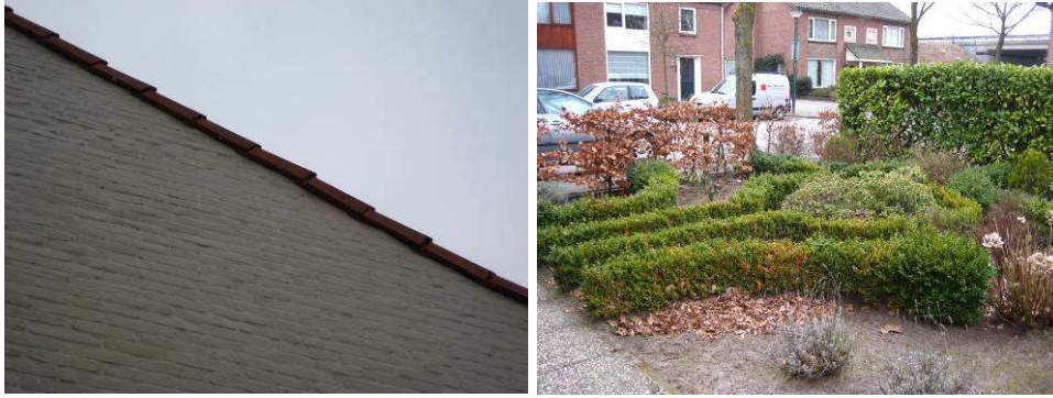
Figuur 5.3. Overhangende dakpannen van de woningen en tuingroen in het plangebied.
