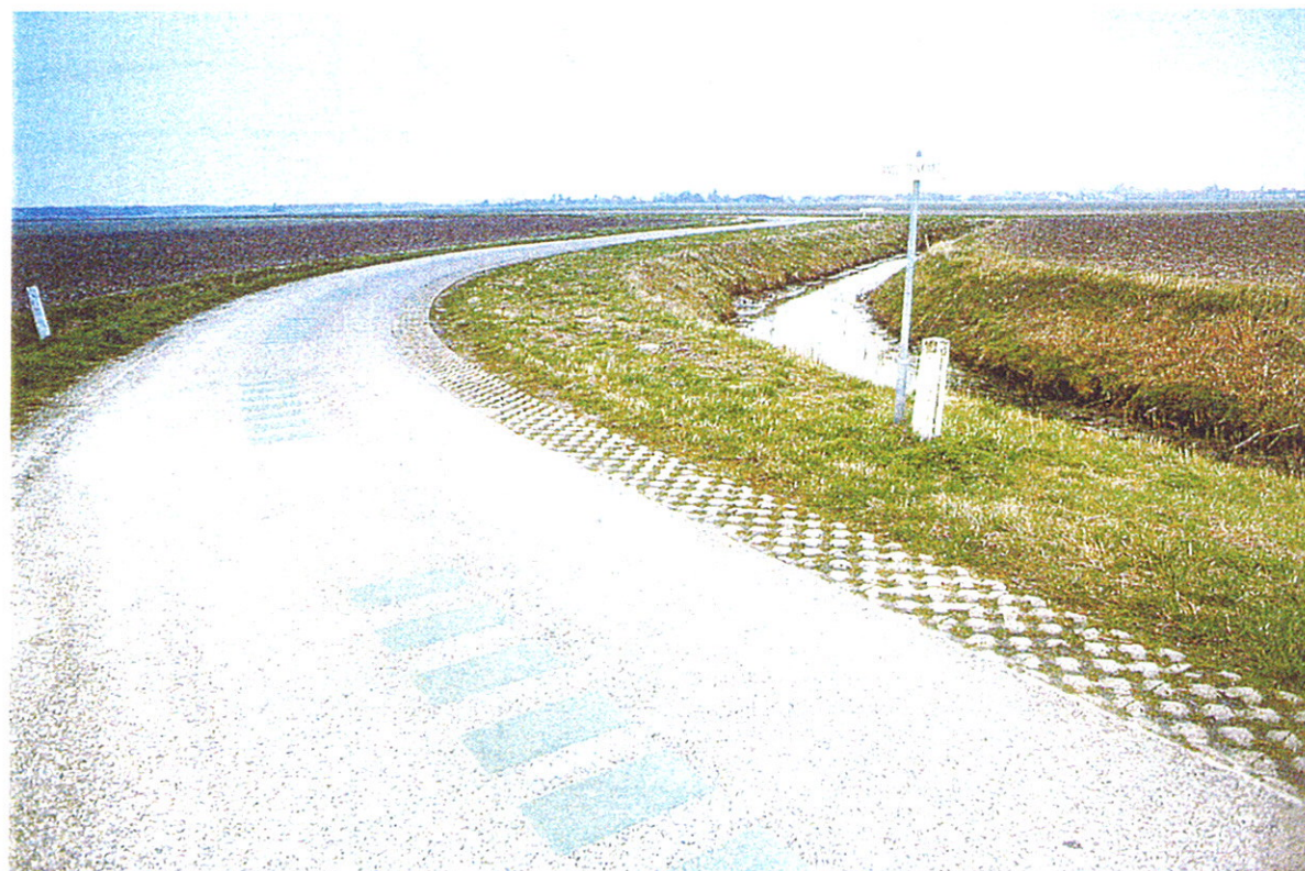
Nieuwe vormgeving erftoegangsweg
