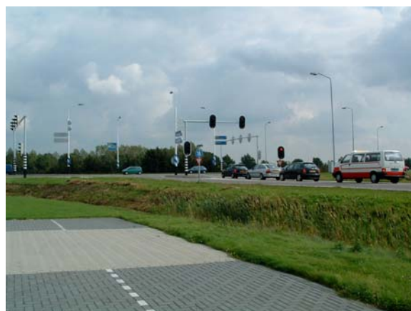
Foto 4 Situatie Bevrijdingsweg vanaf parkeerplaats hotel
