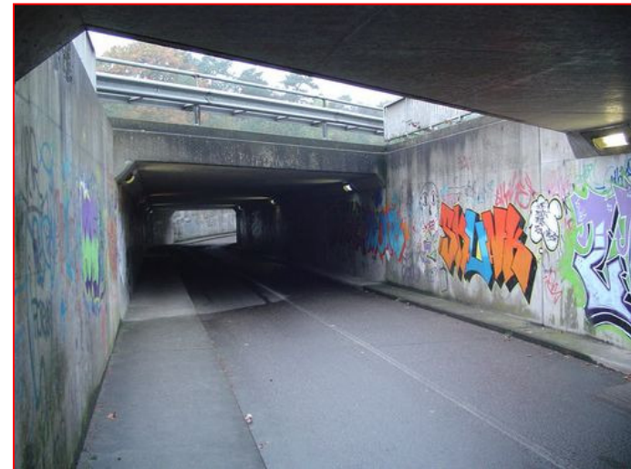
Huidige tunnel onder de N261
