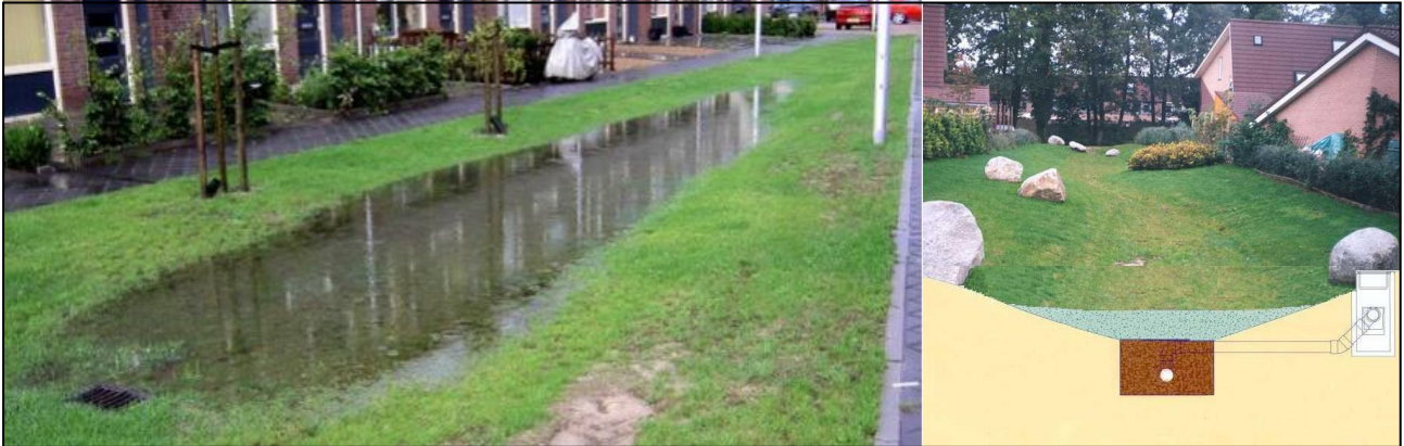
Afbeelding 5: Voorbeeld en schematische weergave van wadi in openbaar groen met drain en overloop
