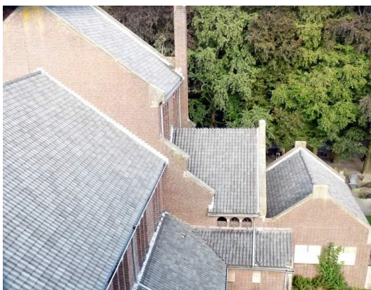
Fig. 5. Dak van de pastorie. Foto genomen vanaf de toren, richting het westen.
