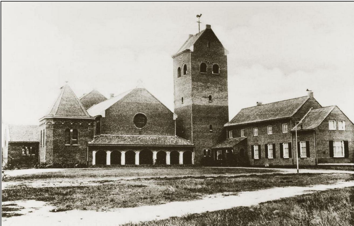
Figuur 3: Foto van de Sint-Jozefkerk en pastorie. De datering is niet bekend, maar gezien de nog niet aangelegde tuin zal de foto kort na de bouw in 1936 zijn gemaakt (Bron: www.reliwiki.nl ).
