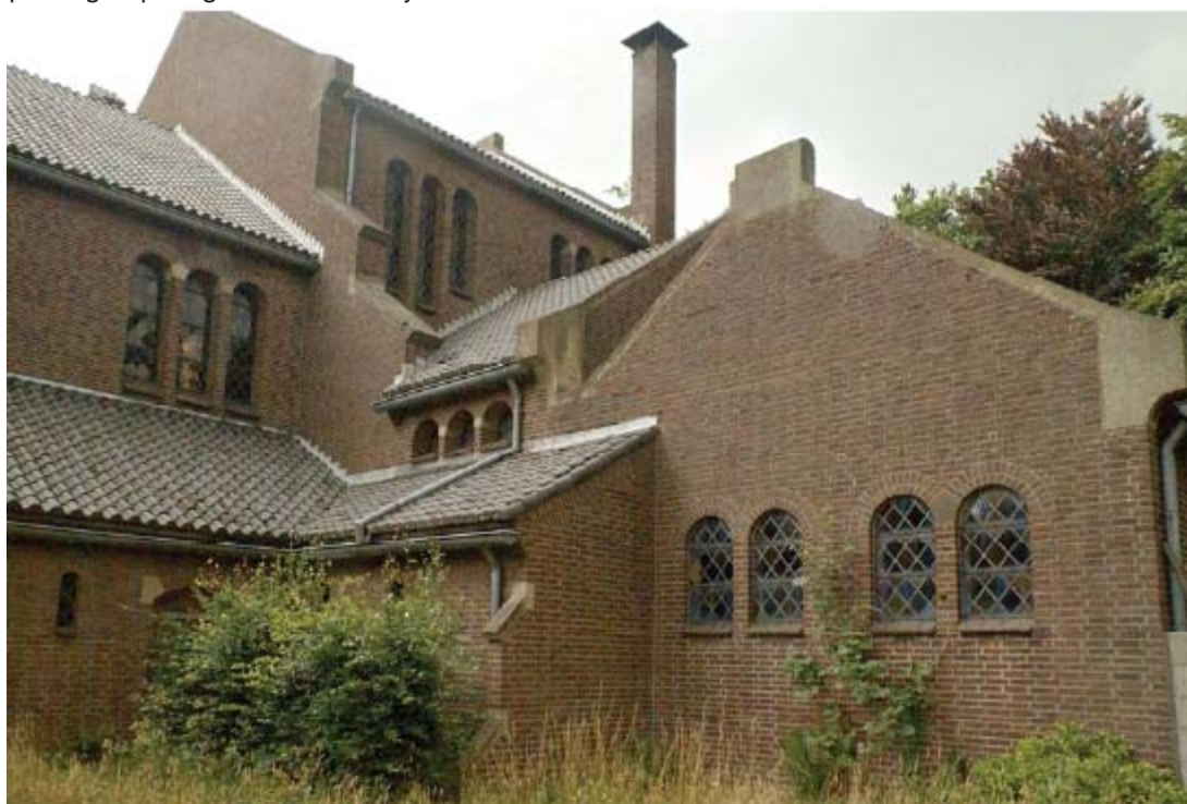
4 De oostpartij vanuit het zuidwesten.
