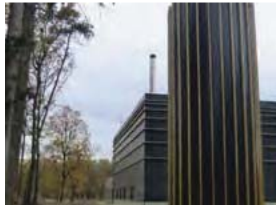
Biomassa centrale Meerhoven
