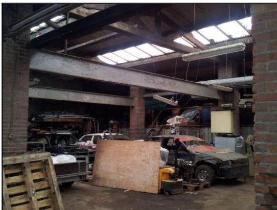
Foto 3: bebouwing in gebruik als opslagruimte
