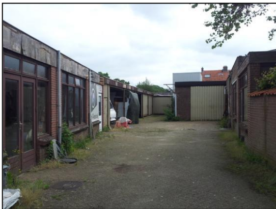
Foto 1: hallen/loodsen gezien vanaf Hoge Steenweg
