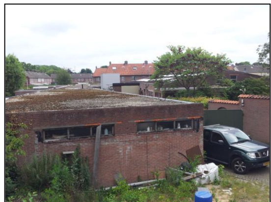
Foto 4: zicht op platte daken hallen/loodsen
