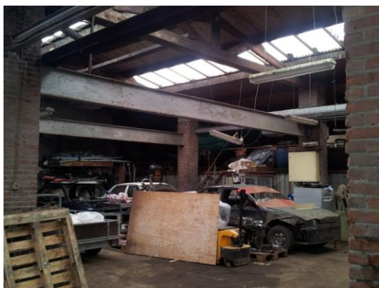
Foto 3: bebouwing in gebruik als opslagruimte
