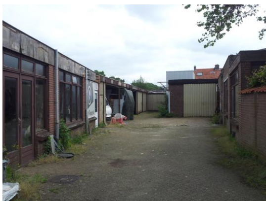
Foto 1: hallen/loodsen gezien vanaf Hoge Steenweg
