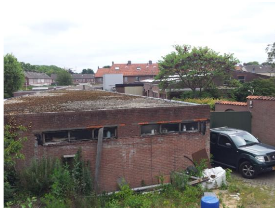
Foto 4: zicht op platte daken hallen/loodsen
