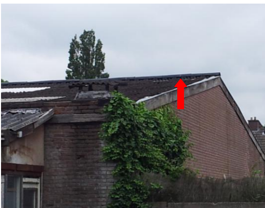
Foto 7: ruimte tussen dakpannen en in nok
