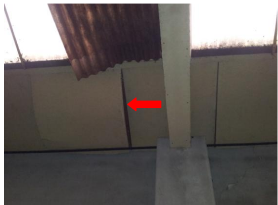
Foto 8: bereikbare ruimte tussen dak en plafond
