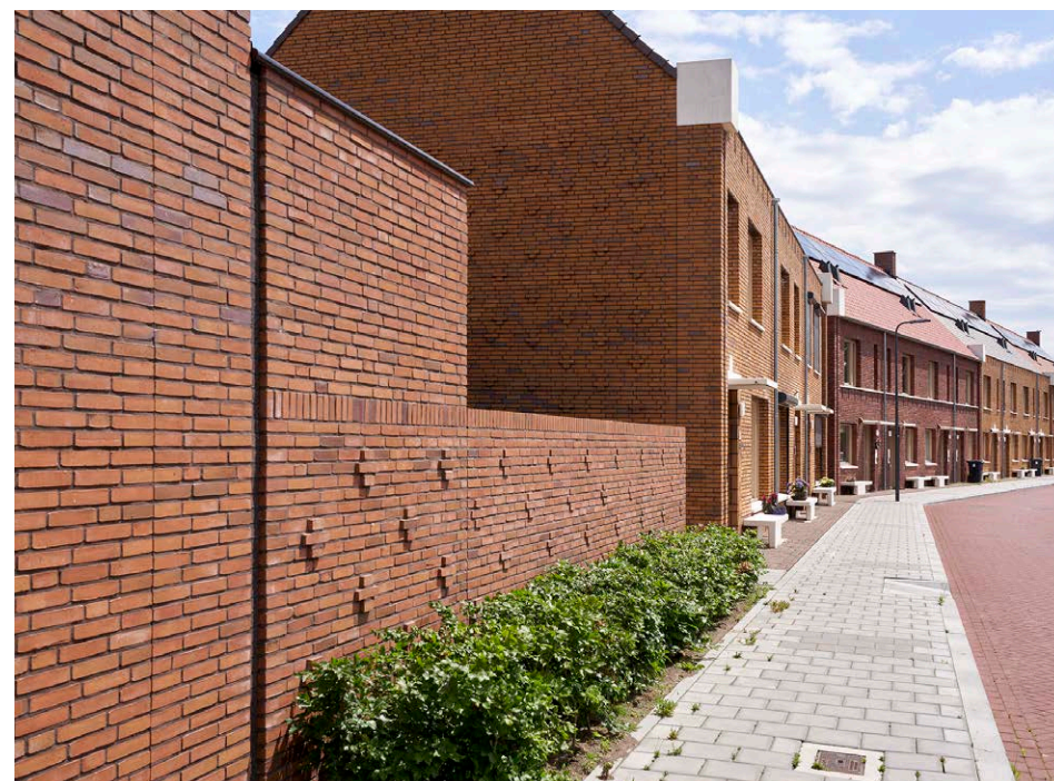
► Tuinmuur, mee ontworpen in architectuur
