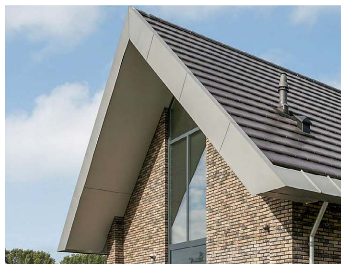
► Dakvorm met overstek.
