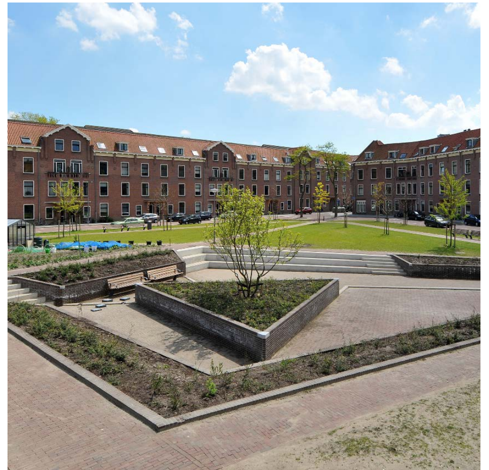
► Centrale, dorpse ruimte met strakke, industriële look en ruimte voor wateropvang
