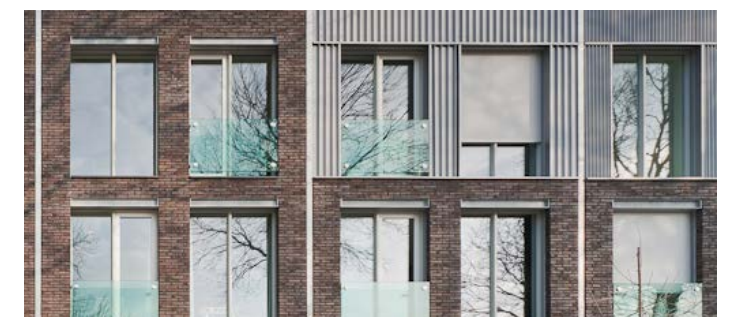
► Staande raamopeningen met terugliggende kozijnen
