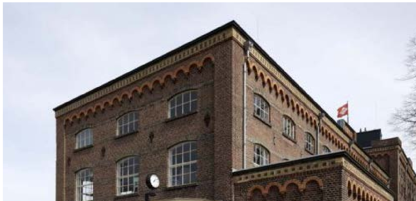
► Plat dak met markante dakrand
