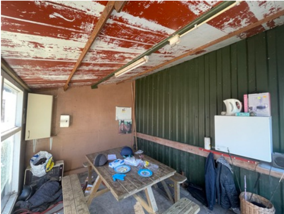
opstal 1. paardenstal (onverdachte aanbouw - kantine)
