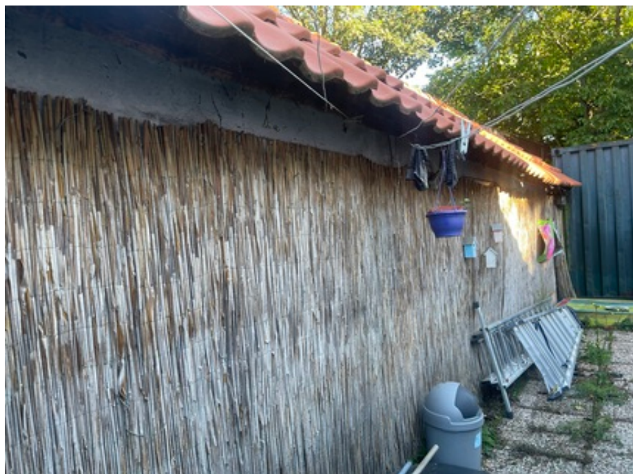
stalramen afgeschermd door rieten matten
