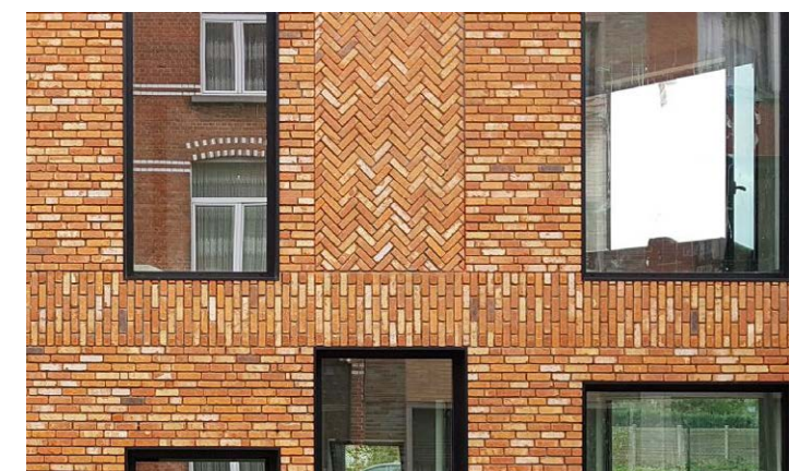
► Het metselwerk kent een zorgvuldige detailering en heeft een industriële uitstraling
