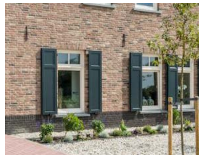
► Het metselwerk wordt bij voorkeur voorzien van verbijzonderingen, zoals een plint, rollagen en andere (kleur)accenten.
