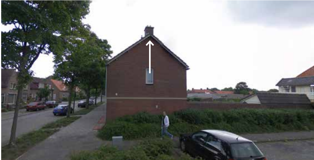
Figuur 4.5: Kraamverblijfplaats Van Salm Salmstraat 14, opening via dakpannen en spleet tussen muur en dakrand.
