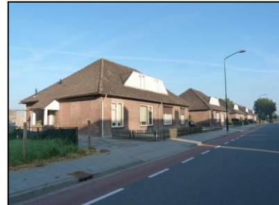
Figuur 4. Te slopen woningen aan de Sweensstraat.
