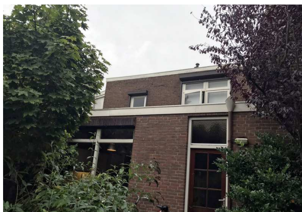
Figuur 11. Achterzijde van de fabriekshal aan de Prins Hendrikstraat.
