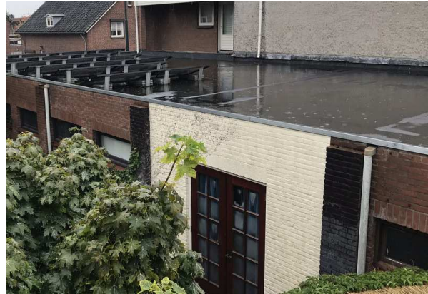
Figuur 7. De hal aan de Gasthuisstraat 125 vana het dak van de fabriekshal gezien.
