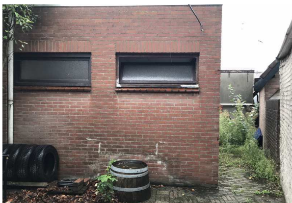
Figuur 10. Achterzijde van de hal aan de Gasthuisstraat.
