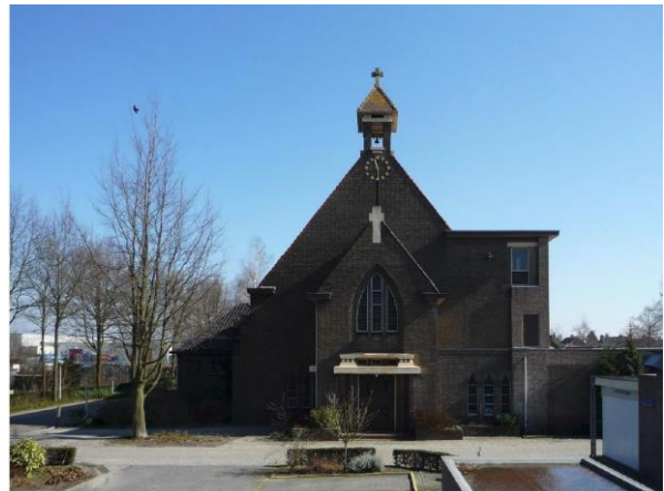
Figuur 2.3: Foto bestaande kapel op Park Vossenberghuis
