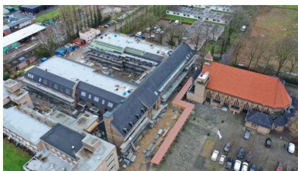
Figuur 2.6: Foto bouwdeel 1 in aanbouw (begin 2020)
