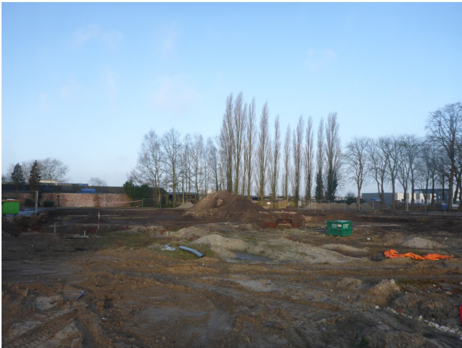
Afb. 1.2 Het plangebied ter hoogte van werkput 2. Foto genomen richting het westen.
