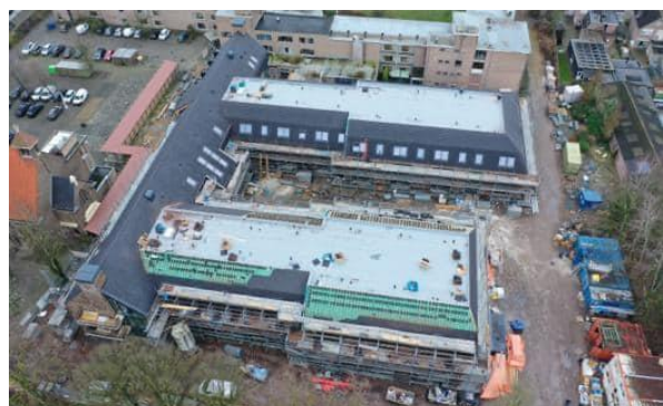
Figuur 2.7: Foto bouwdeel 1 in aanbouw (begin 2020)
