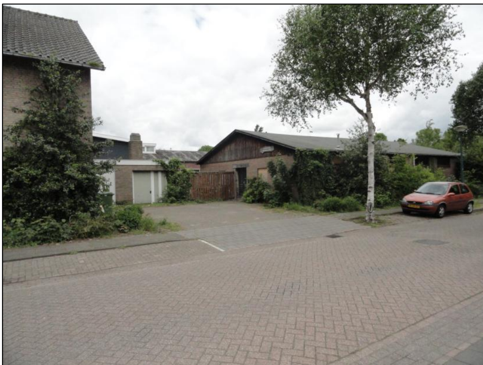
Figuur 13: Zicht op enkele naoorlogse panden aan de Ringvaart met huisnummer 82
