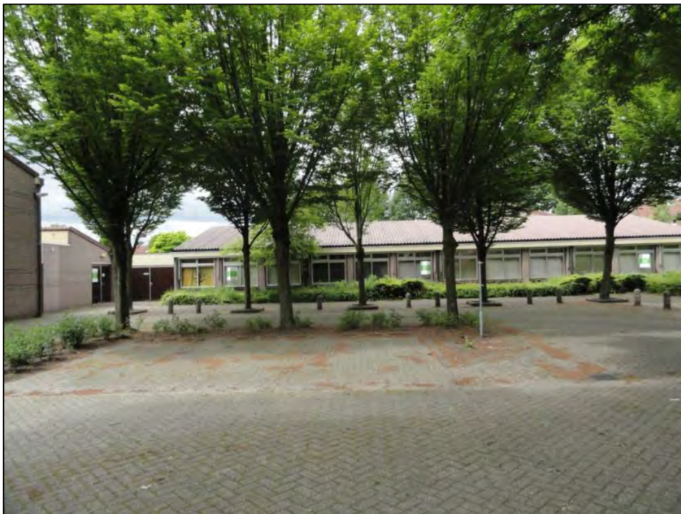
Figuur 19: het centrale deel van de voormalige Rooms-Katholieke Anton Pieckschool.
