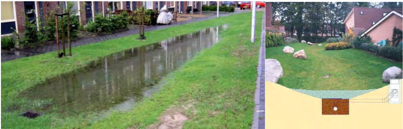
Afbeelding 4: Voorbeeld en schematische weergave van wadi in openbaar groen met drain en overloop
